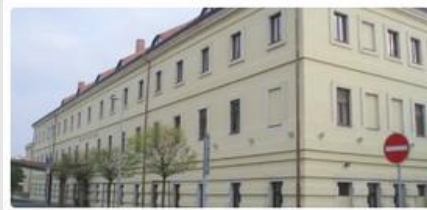
Komerční a veřejné stavby Hotel Tereziánský dvůr
