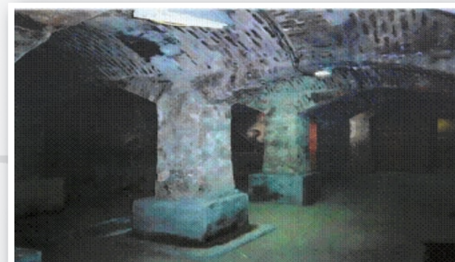
Izolace základových desek v suterénu Zábavní centrum Babylon-Liberec, 5600m 2 GD: HAVAX v.o.s. Liberec, 1999
