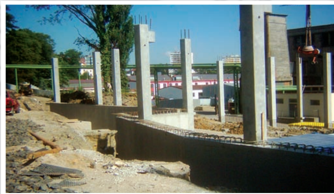
Izolace spodní stavby Hotel Babylon v Liberci, 2300 m 2 GD: Havax a.s., 2001
