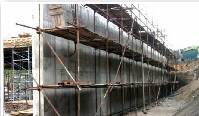
Izolace spodní stavby SUS v Jablonci nad Nisou, 1100m 2 GD: Regionální stavební s.r.o., 1999
