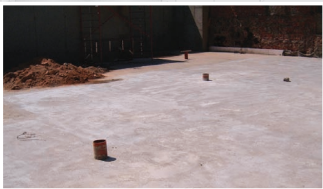
Izolace základové desky Pneuservis Obnova Liberec 300 m 2 , GD: Havax a.s. Liberec, 2006
