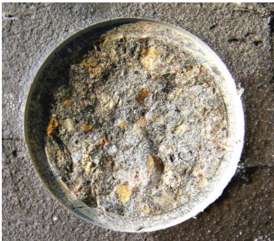
Zkouška přilnavosti s lepidlem Silipox 826. Dokonalá přilnavost - dokonce i na mokřém betonu!
