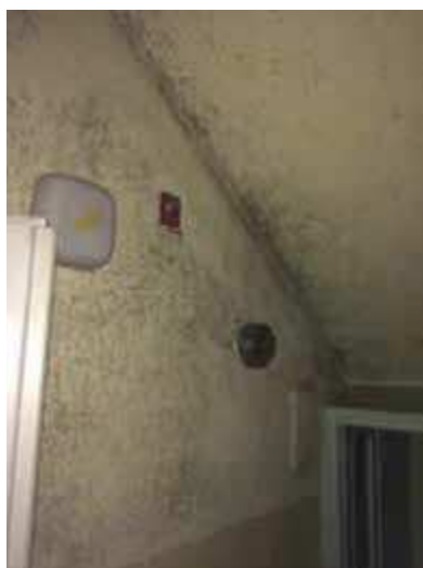
Obr. 2 - Plísně u důsledku nerespektování fyzikálních zákonů v nových objektech
