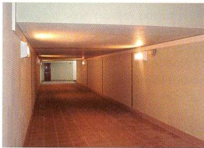
Podchod po opravě
