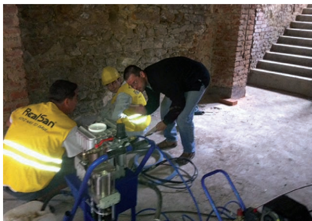
Průběh a měření kvality gelových injektáží
