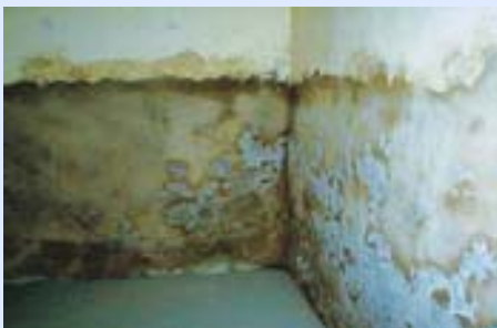
Při aplikaci omítek na extrémně vlhké zdivo se na stěnách objevují solné výkvěty a plísně
