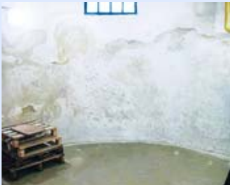
Při aplikaci omítek na extrémně vlhké zdivo se na stěnách objevují solné výkvěty a plísně
