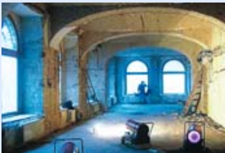
Při použití vysoušečů a odvlhčovačů vzduchu je třeba zajistit uzavření okenních a dveřních otvorů
